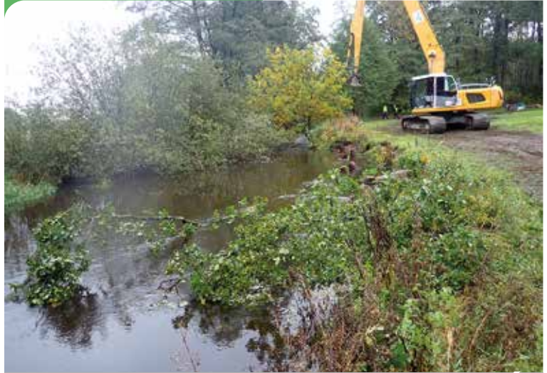
Eine große Eiche samt Krone wurde in die Aufweitung der Örtze gelegt und mit großen Pfählen gesichert. Sie schützt das Ufer vor weiteren Abrüchen und bietet gute Unterstände für die Fischfauna.
