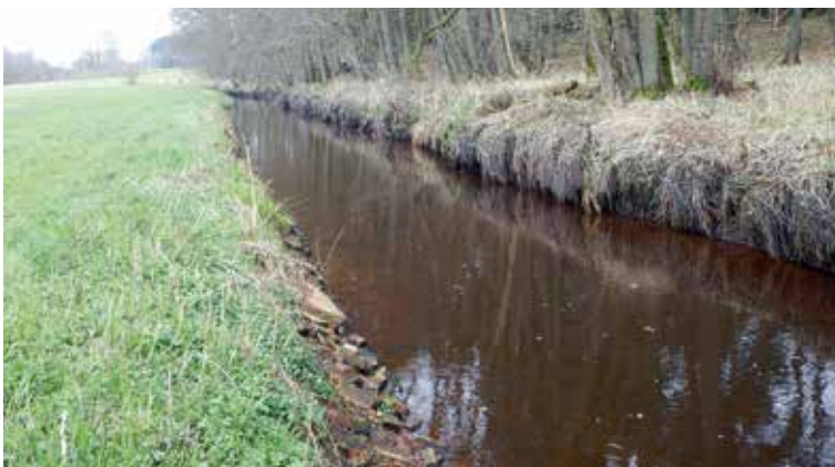
Der Gohbach wurde einst begradigt und die Ufer mit Bauschutt befestigt.
