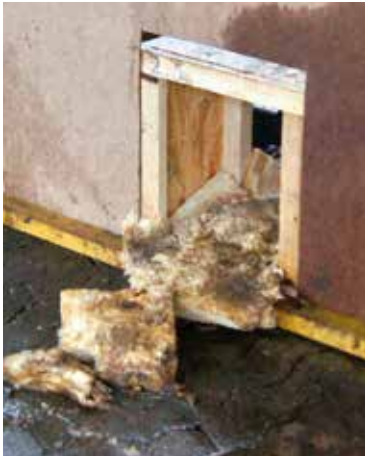
Wenn sich Steinmarder ihren Schlafplatz auf dem Dachboden herrichten, müssen Dämmstoffe schon einmal beseitigt werden.
