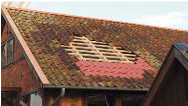
Noch sieht man an der Steinmarderscheune die ausgetauschten Balken.
