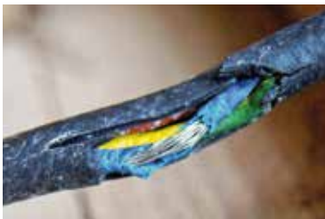
Kabelschäden durch Steinmarder können erhebliche Kosten nach sich ziehen: sei es an der Photovoltaikanlage oder im Fahrzeug.
