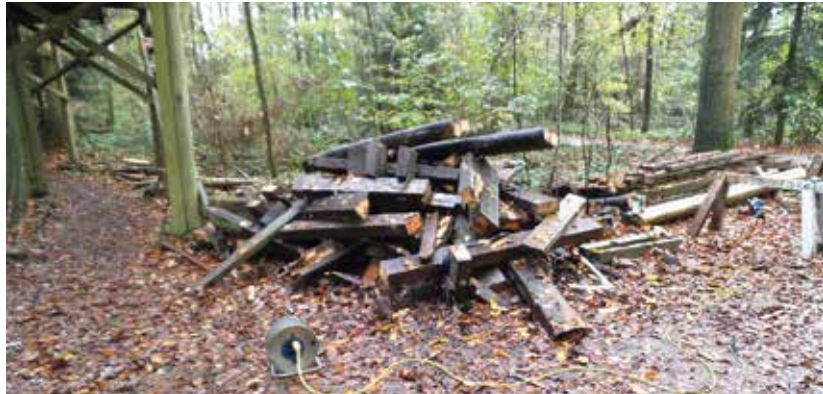
Under construction – das Baumardergehege wird saniert.
