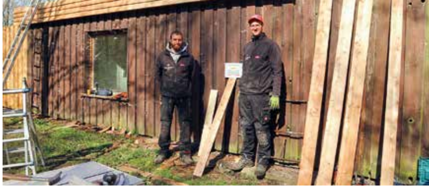
Die Dachdecker mussten etliche Balken und Bretter austauschen.
