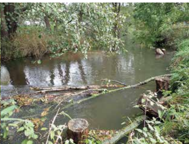
Die Strukturvielfalt erhöht sich mit dem Einbau von Totholzelementen und einzelnen Findlingen.
