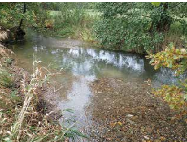
Durch Einbau von Kiesbetten wurde das fehlende Hartsubstrat in die Lehrde zurückgebracht.
