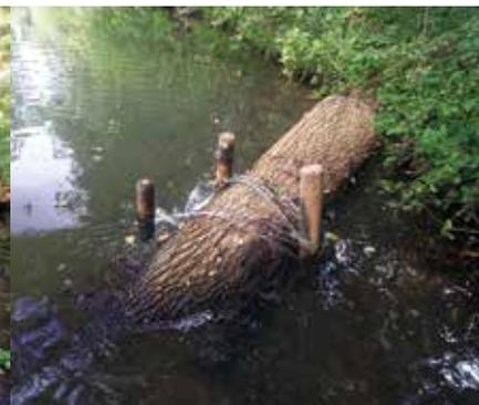
*Dicke Stammstücke werden mit Draht an Pfosten befestigt.*
