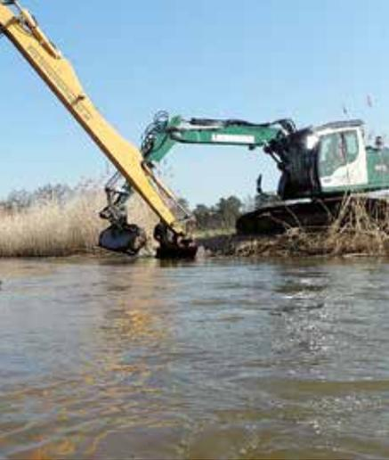
*Mithilfe eines Langarmbaggers konnte trotz der Breite des Gewässers ein Großteil der Maßnahme von nur einer Uferseite ausgeführt werden.*
