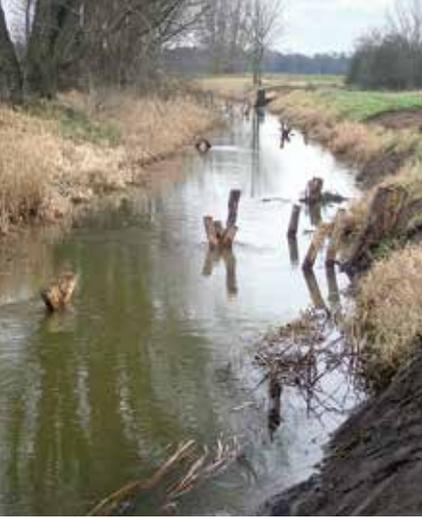
*Lenkbuhnen, Kies und Raubäume wurden wechselseitig eingebaut. So entstehen neue Lebensräume und die Strömungsvielfalt wird erhöht.*
