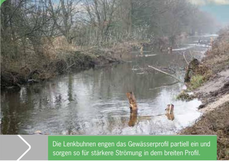
Die Lenkbuhnen engen das Gewässerprofil partiell ein und sorgen so für stärkere Strömung in dem breiten Profil.
