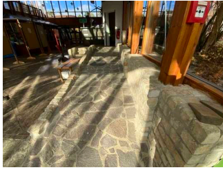
Rampe zum WC
