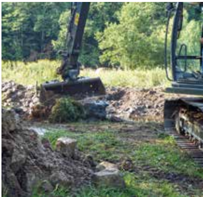
Betontrümmer wurden nach der Sprengung eines alten Wehres aus der Ise entfernt.
